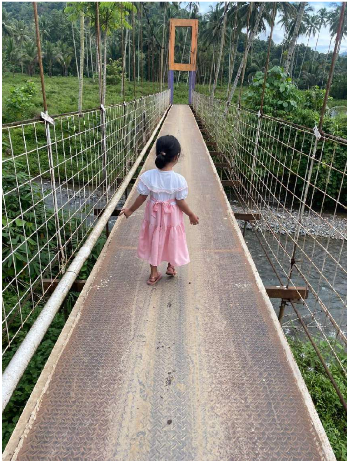
Dokumentasi : jembatan gantung, salah satu Akses menuju SD Negeri Mengkang (Jembatan Gantung)
