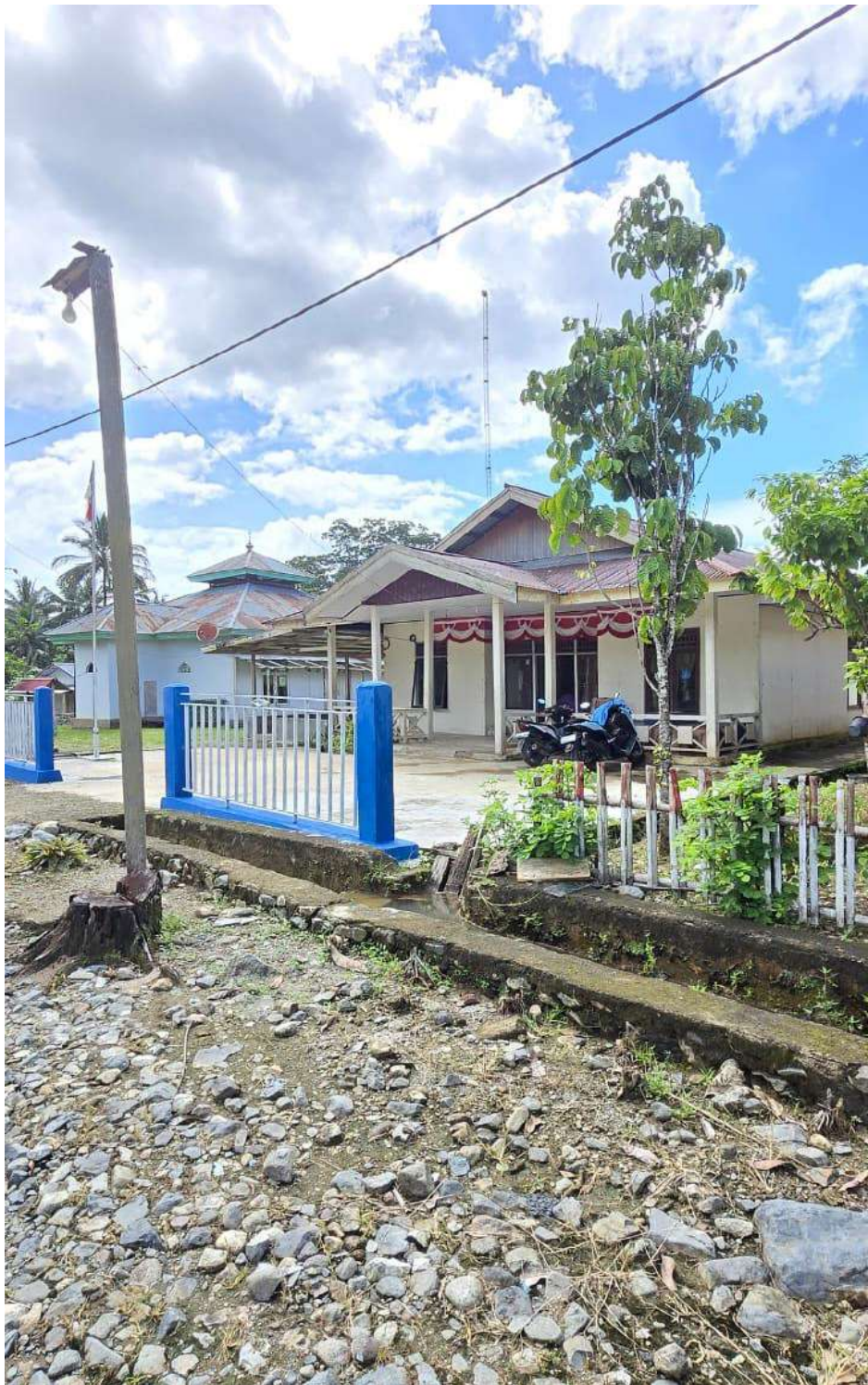
Balai Desa yang berdampingan langsung dengan SDN Mengkang
