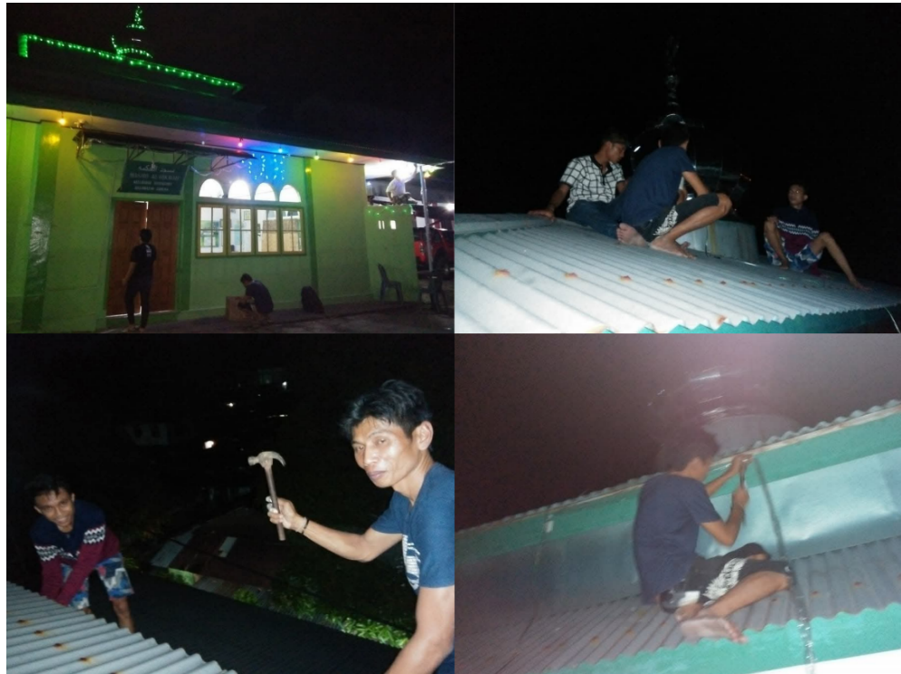
(Lampiran 1.7 Pemasangan Lampu atap Masjid, 5 Juni 2018 {Dokumentasi; media sosial Ikatan Remaja Masjid Al-Hikmah})
