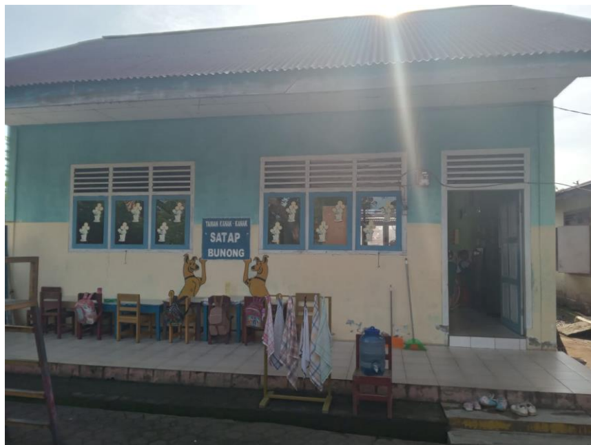
Gedung Sekolah TK Satap Bunong
